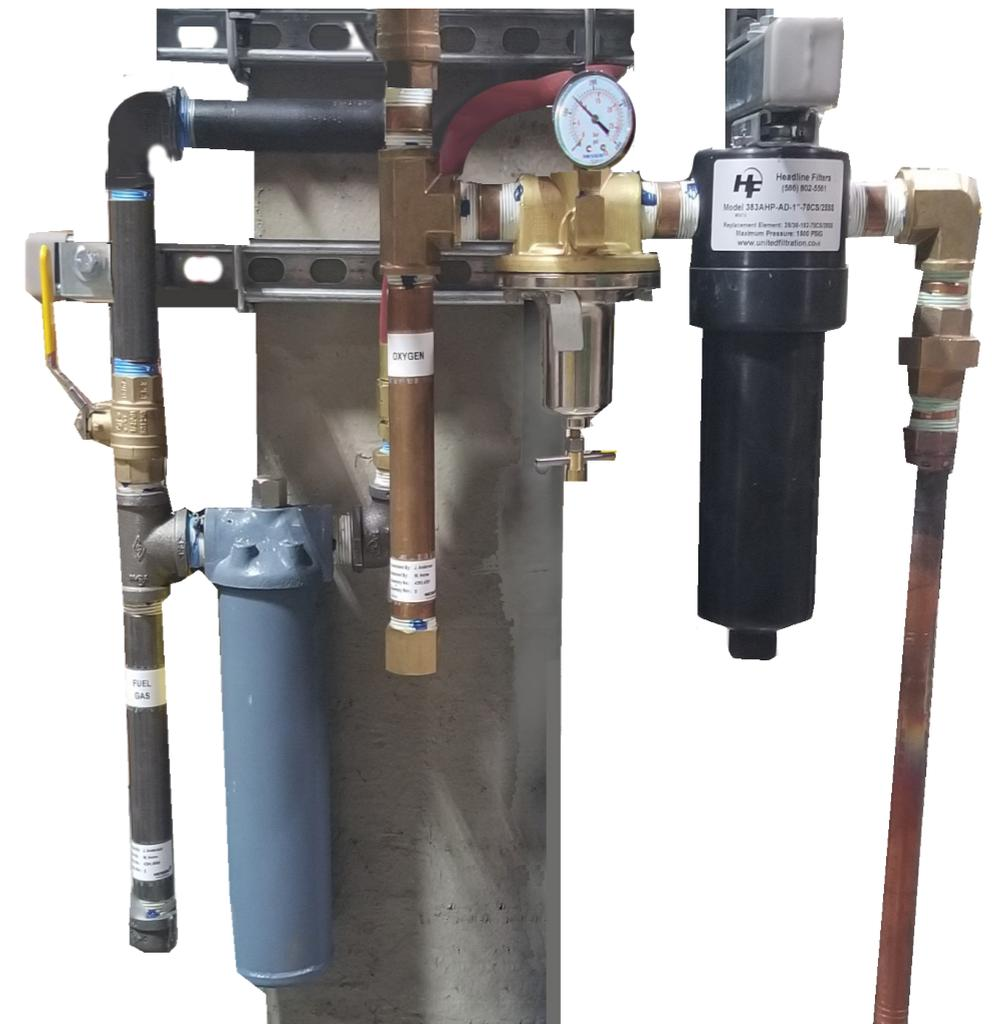
Equipo de estación de oxicorte montado por el cliente.
